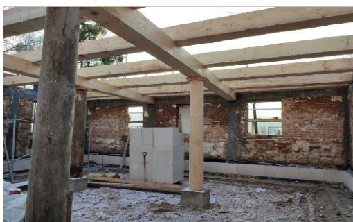
konstrukcja poddasza
