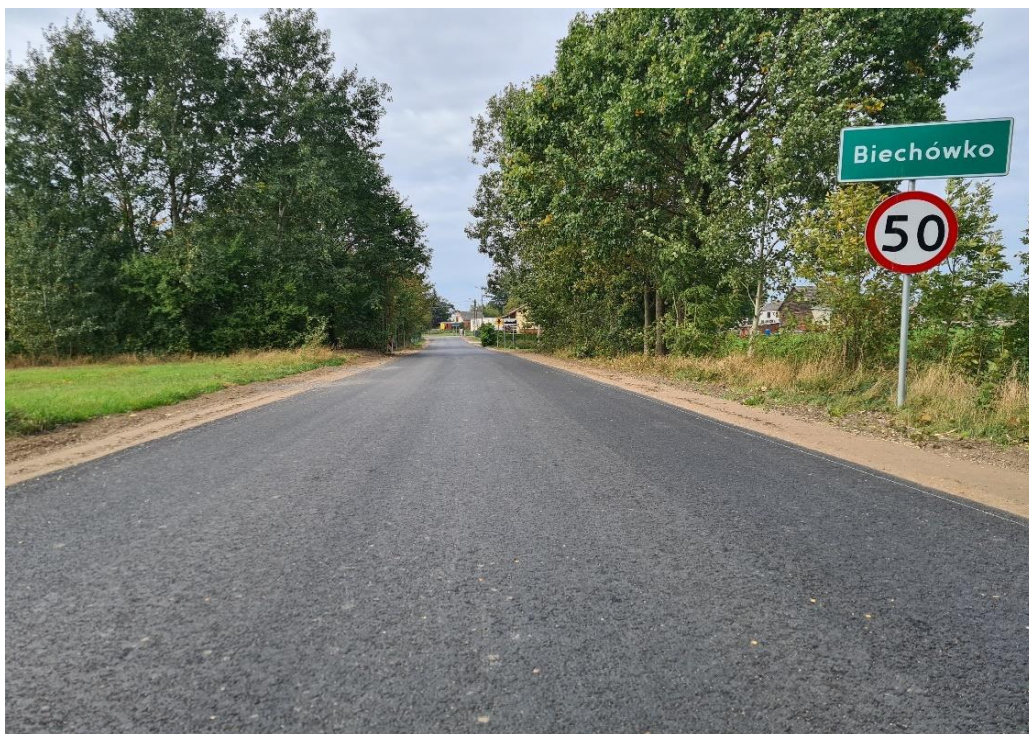
Fot.: Droga powiatowa nr 1245C w Biechówku, źródło: własne
