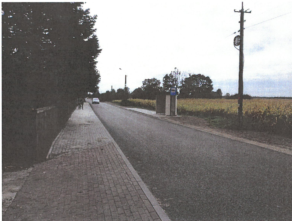
Fot.: Droga powiatowa nr 1244C w Dąbrówce, źródło: własne
