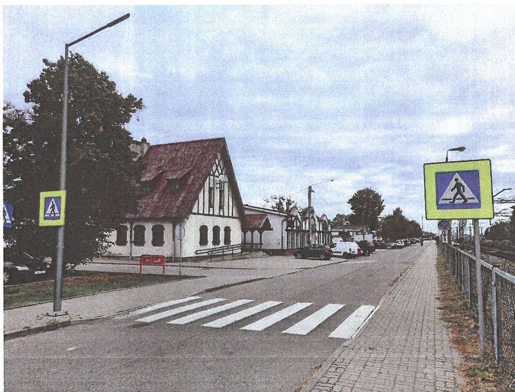
Fot.: Przejście dla pieszych ul. Dworcowa w Pruszczu, droga 1278C, źródło: własne
