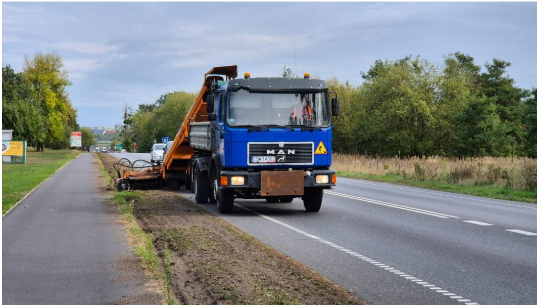
Fot. nr 5: Praca ścinarką poboczy na drodze powiatowej nr 1286C, źródło: własne
