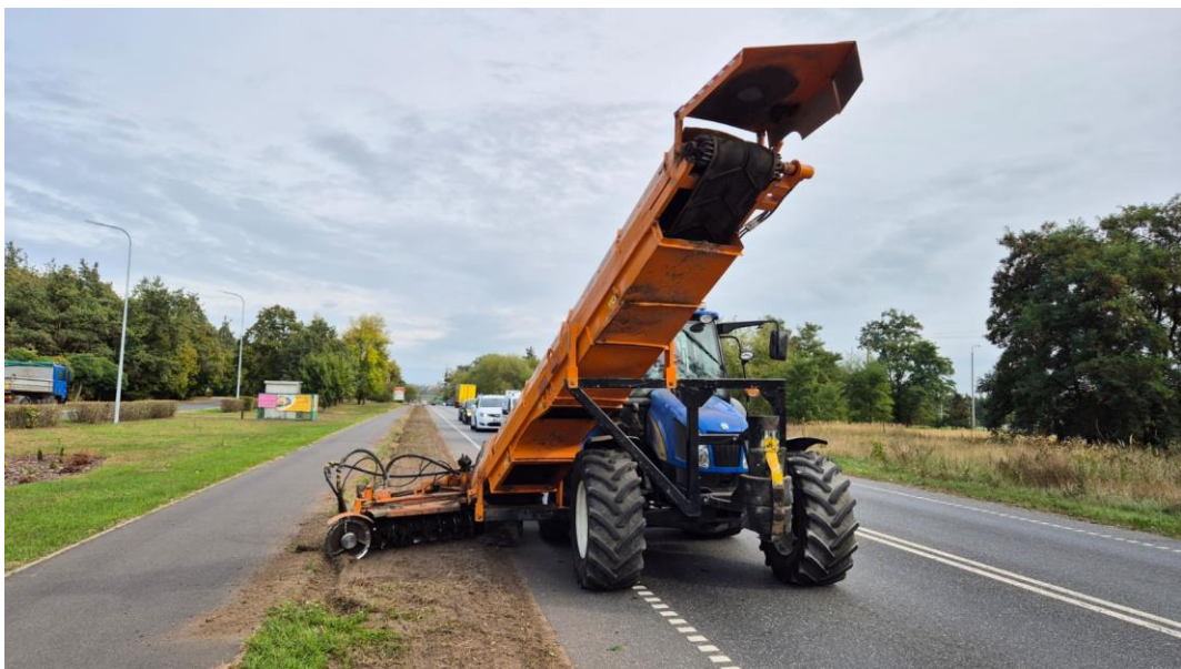
Fot. nr 6: Praca ścinarką poboczy na drodze powiatowej nr 1286C, źródło: własne
