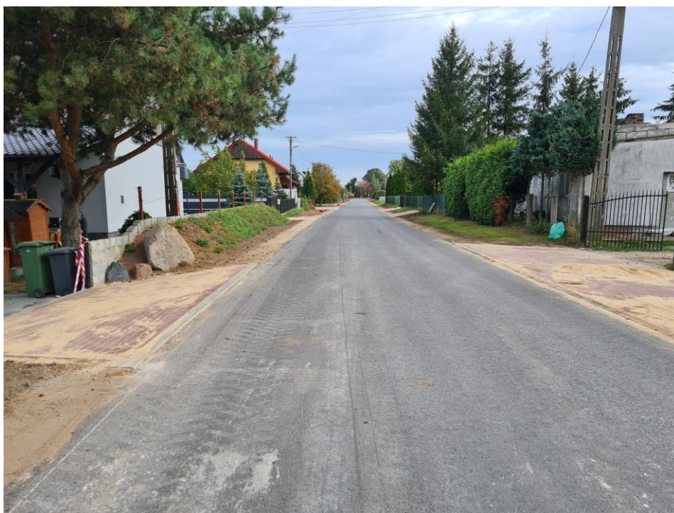
Fot. nr 26 Droga powiatowa nr 1246C, źródło: własne
