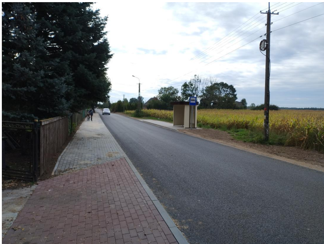
Fot. nr 18 Droga powiatowa nr 1244C, źródło: własne
