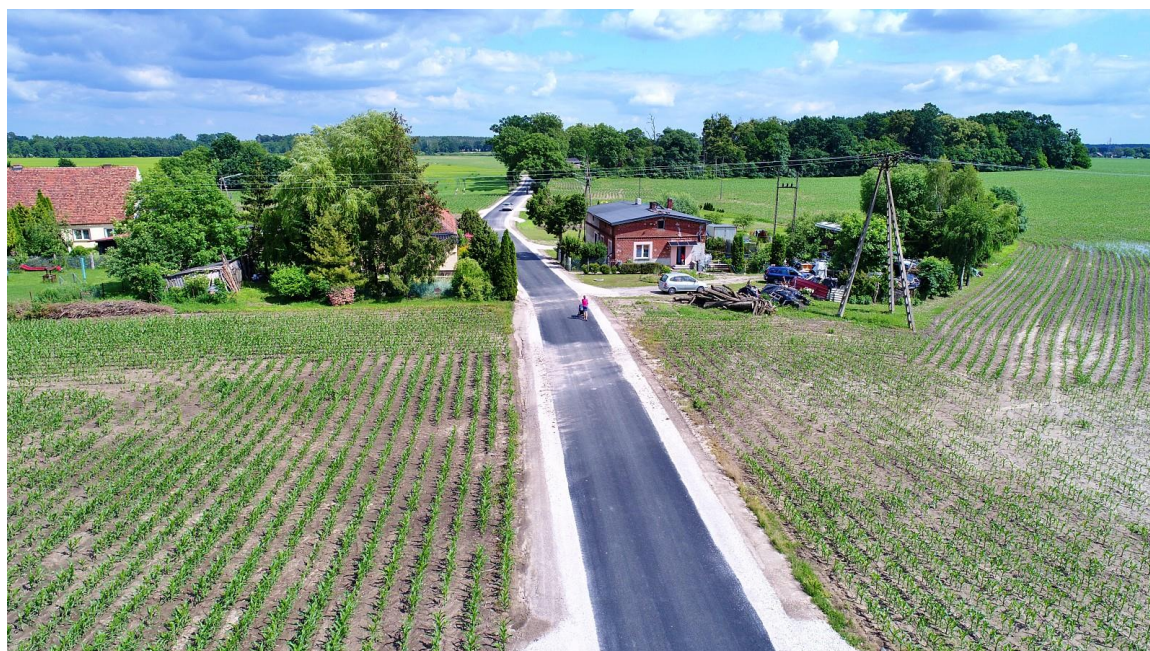
Fot. nr 12 Remont drogi powiatowej 1239C, źródło: www.bukowiec.pl
