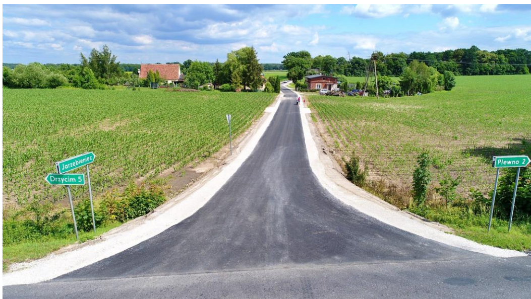
Fot. nr 10 Remont drogi powiatowej 1239C, źródło: www.bukowiec.pl
