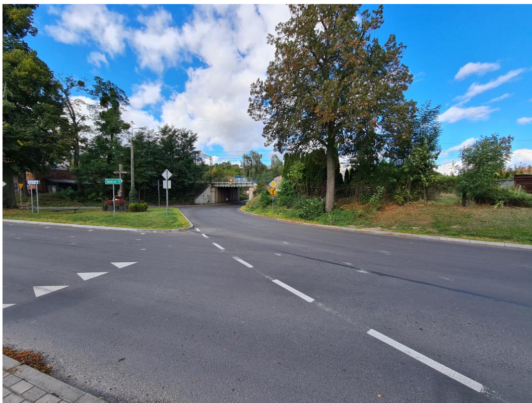
Fot. nr 17 Droga powiatowa nr 1293C w miejscowości Terespol, źródło: własne
