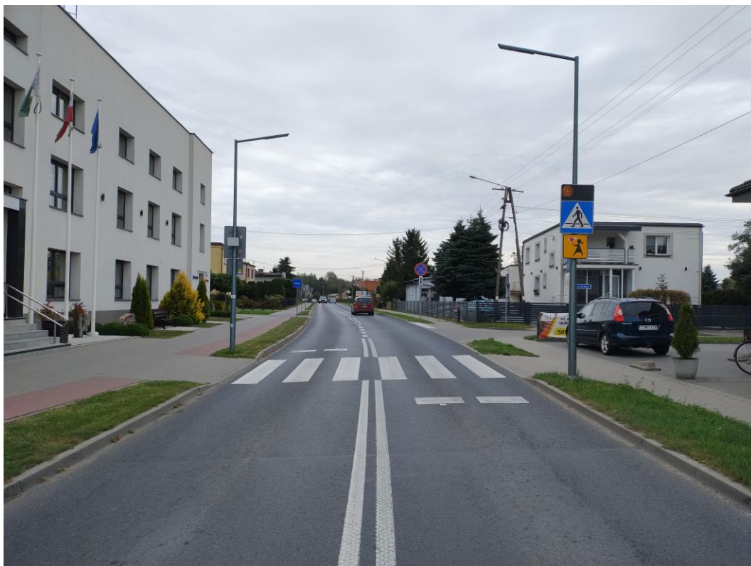
Fot. nr 5 Przejście dla pieszych w pobliżu Urzędu Miasta i Gminy Pruszcz, droga 1266C, źródło: własne
