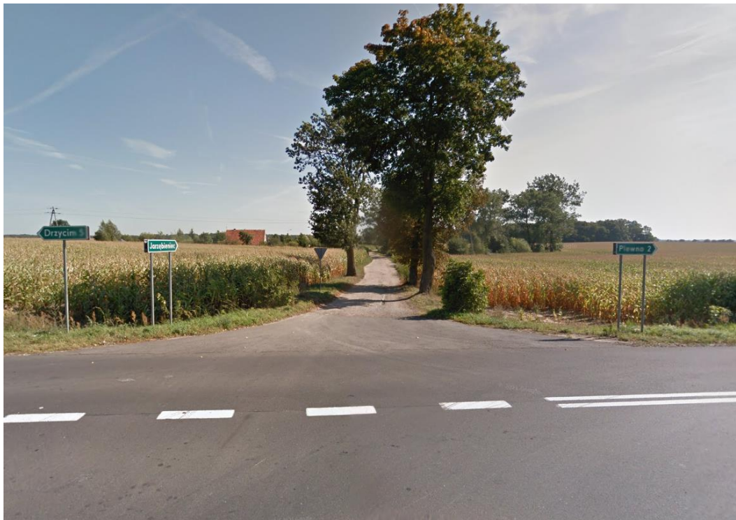
Fot. nr 9 Droga powiatowa nr 1239C przed remontem, źródło: google.pl/maps
