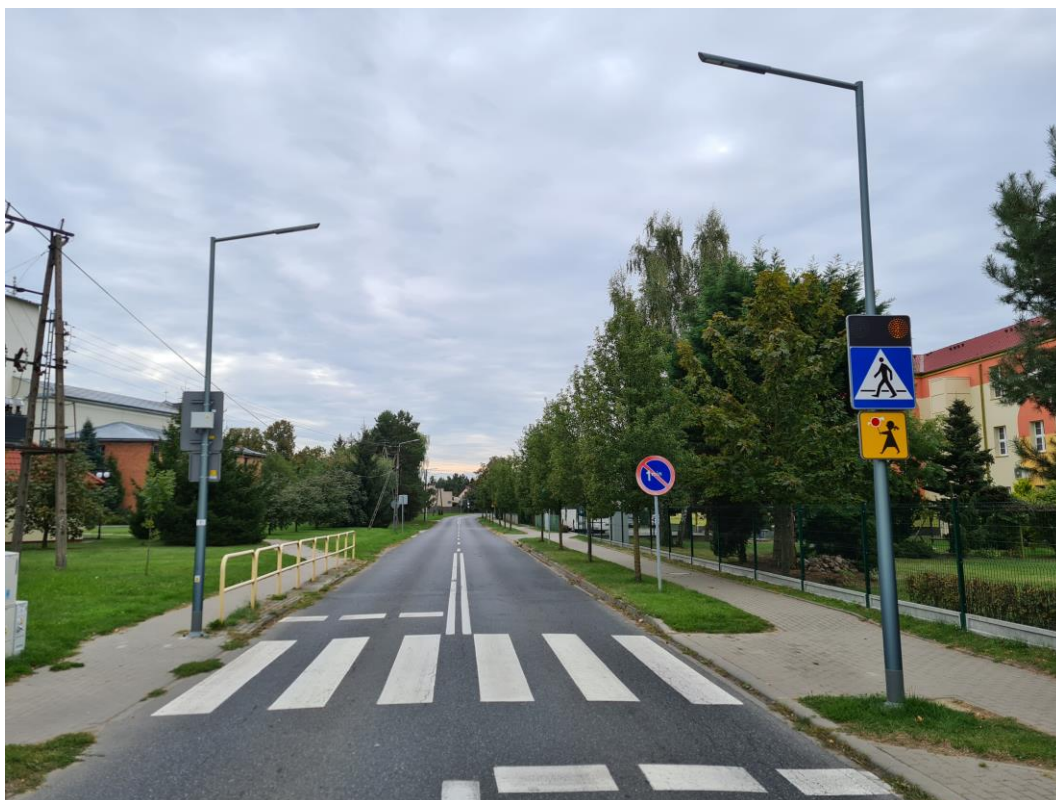
Fot. nr 4 Przejście dla pieszych ul. Kościelna, droga 1271C, źródło: własne
