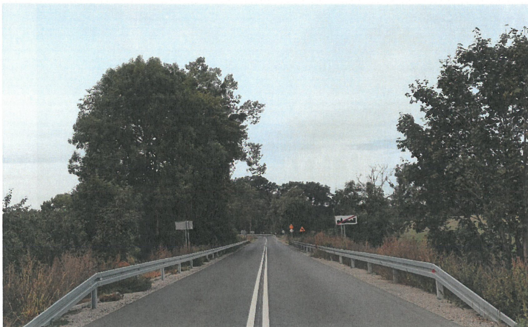
„Przebudowa drogi powiatowej nr 1048C Osie – Warlubie” dofinansowanej w ramach Rządowego Funduszu Rozwoju Dróg oraz środków z Funduszu Leśnego
