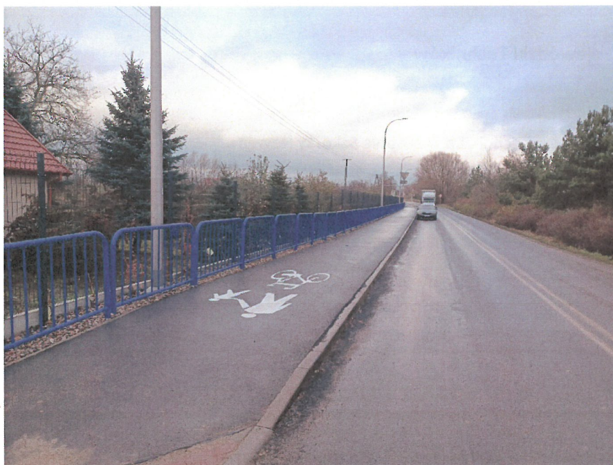
„ Budowa ciągu pieszo - rowerowego przy drodze powiatowej nr 1289C Świecie - Głogówko Królewskie” dofinansowanego w ramach Rządowego Funduszu Polski Ład: Program Inwestycji Strategicznych
